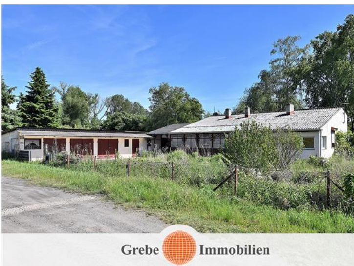
Blick von der Straße
